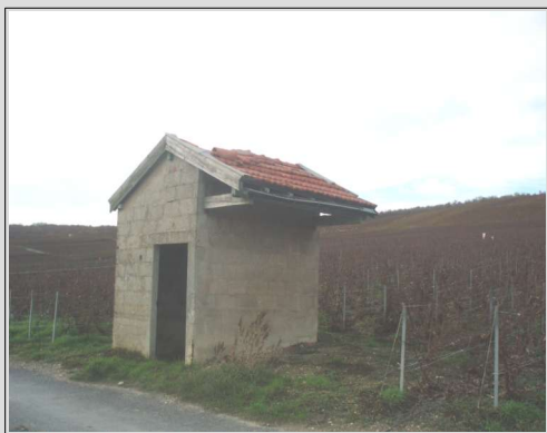
Aux « Grandes sentes » 2011 © C Chevry Construite par Paul Quénot. Murs en parpaings, toit à deux pentes en tuiles, porte et fenêtre en bois.
