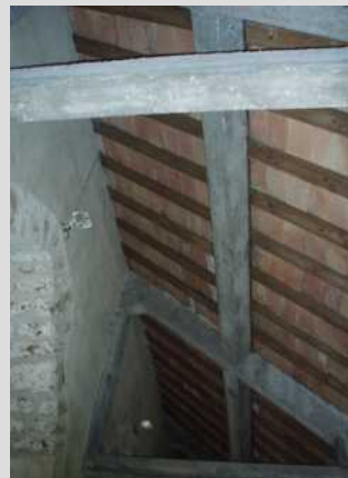
Charpente en béton
