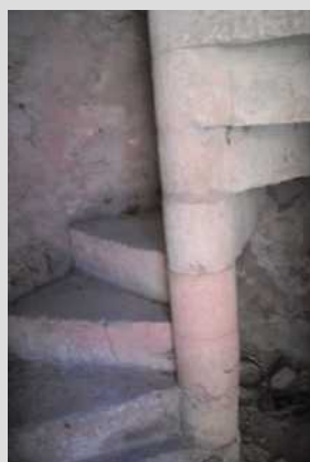
Escalier de la tourelle
