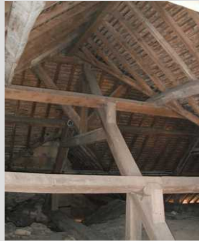
Charpente des combles
