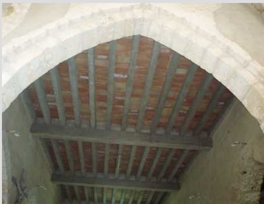
Charpente en béton
