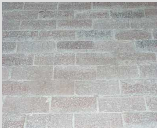
Dalles en briques de la nef
